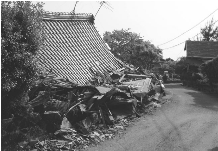
倒壊した家屋 (益城町で撮影)
