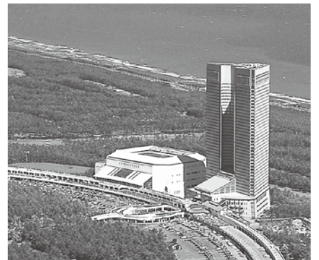
大会会場となるシーガイア コンベンションセンター(建物左側)
